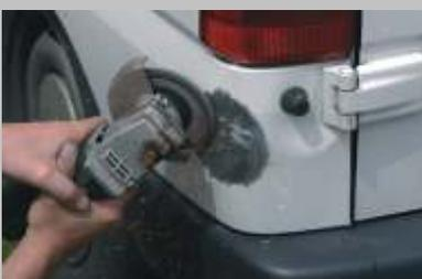
Nach erfolgter Instandsetzung werden der Wellendraht oder die Anschweißplatten abgebogen und mittels Schleifscheibe entfernt.
